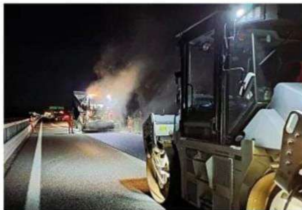
L'intervento Durante la ripavimentazione l'asfalto vecchio viene tenuto e riciclato
