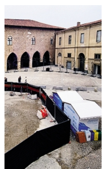
I lavori in piazza FOTO BEDOLIS
