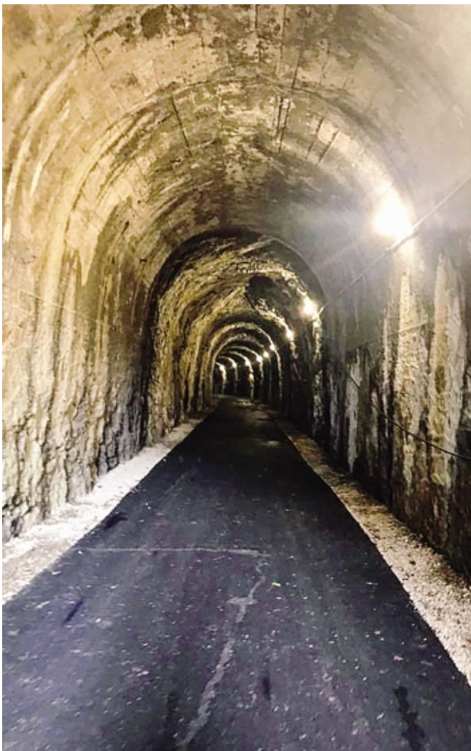
Una delle gallerie in fase di ultimazione, a Botta di Sadrina
